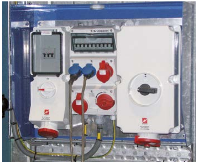
Staalproducent Arcelor Mittal , Genk – België
